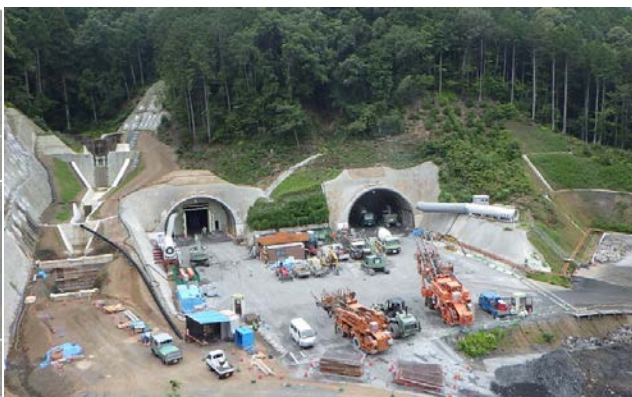
写真①：トンネル坑口全景(終点側)
