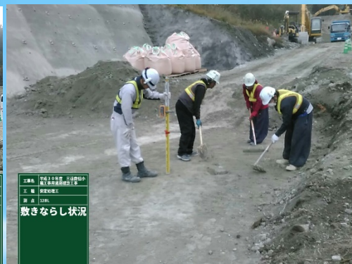
レーザーレベルによる 高さ確認
