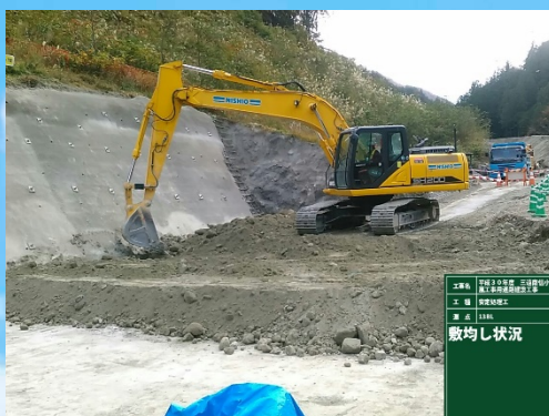
MCバックホウによる 敷均し
