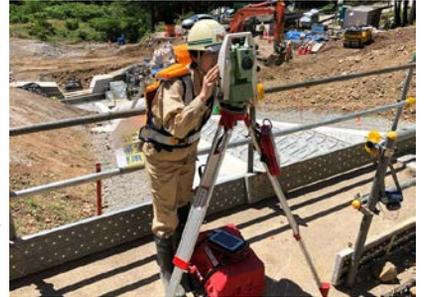
地表面沈下測定 (測量)
