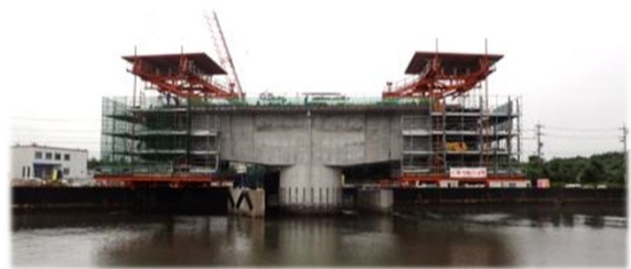
移動式作業車ワーゲンによる 張出し施工
