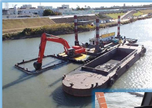
河川浚渫状況
