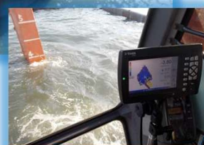
マシンガイダンスを用いた河川浚渫
