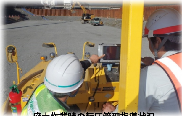
盛土作業時の転圧管理指導状況
