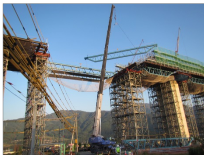
支保工架設状況
