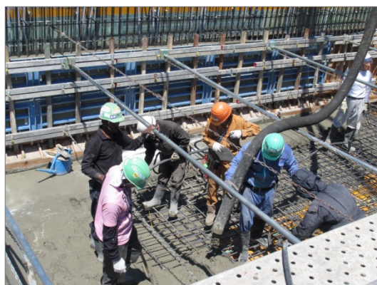
コンクリート打設管理中
