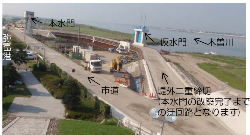
施工中の写真（H27.7時点）
