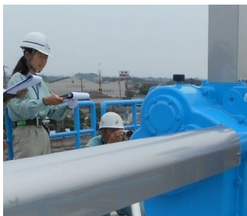
仮水門の動作確認
