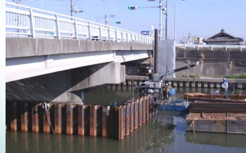
【上部障害クリア工法による仮締切状況】
