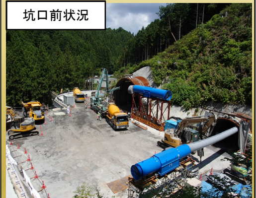
トンネル施工状況
