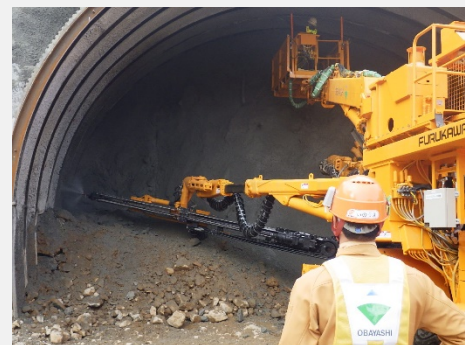
トンネル施工管理
