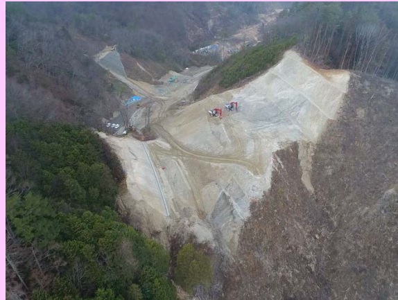
②土砂掘削状況(R3.2撮影)
