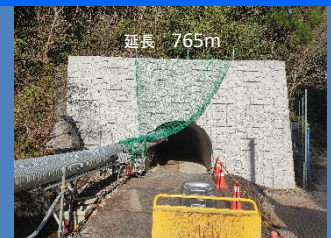
排水トンネル (内部で排水のための ボーリング工事中)
