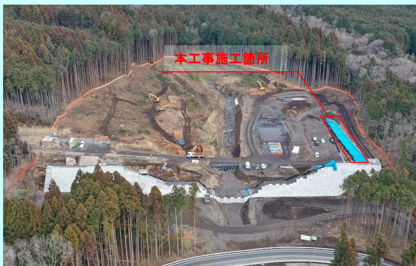
遊砂地下流から上流を望む(令和3年1月末現在)
