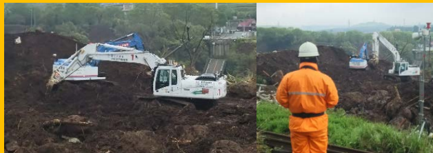
H28熊本地震での遠隔操縦による作業状況
