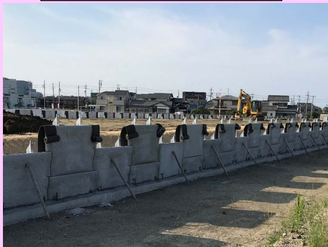
補強土壁工事 作業イメージ
