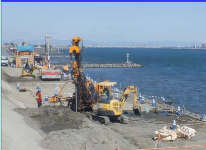
砂圧入式静的締固め工法 (SAVE-SP 工法)
