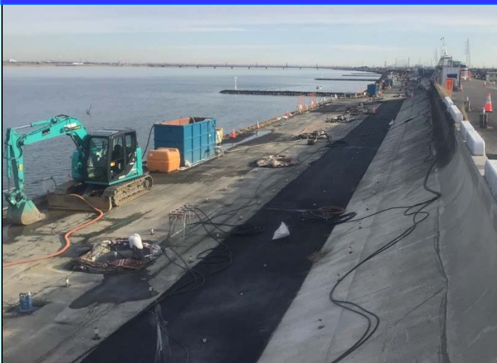
注入固化工法 (浸透固化処理工法)
