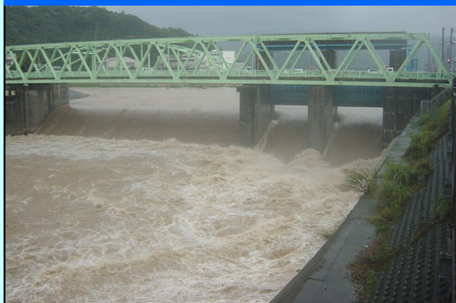
洪水時の放水路状況（平成19年9月）
