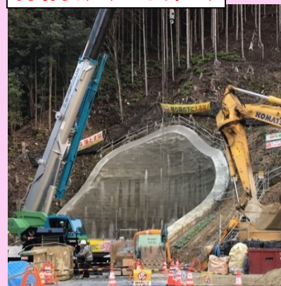
現場状況(P1下部工)
