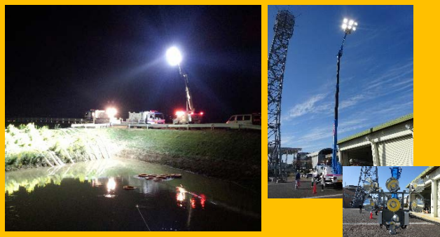
令和元年台風19号 LEDライト式照明車 での照明作業 が新登場
