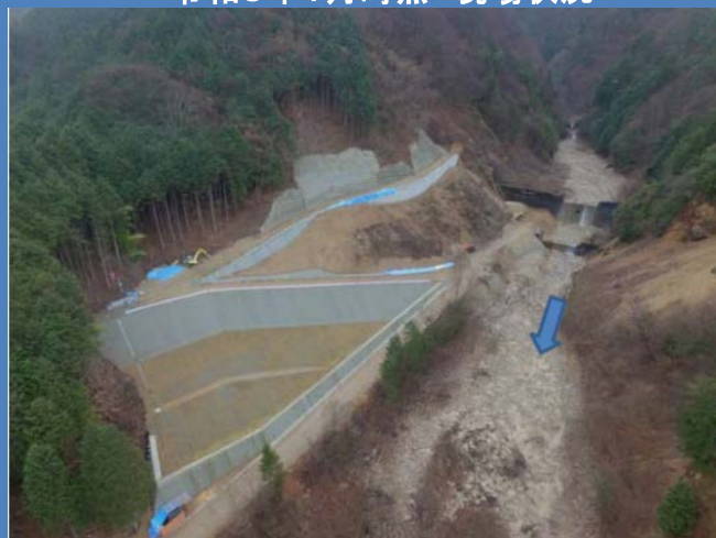
令和3年1月時点 現場状況
