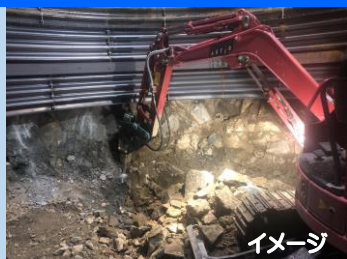
深礎杭 掘削の様子
