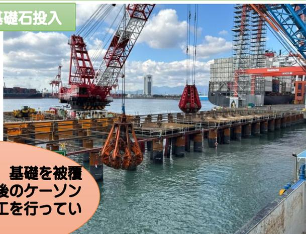
基礎工完了後は、基礎を被覆する被覆工や背後のケーソンを設置する本体工を行います。
