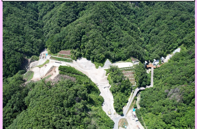
②土砂掘削状況 (R4.7撮影)
