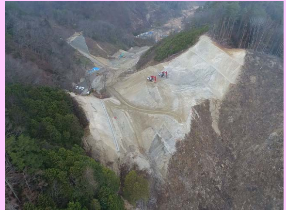
②土砂掘削状況(R3.2撮影)
