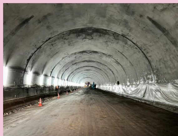
②トンネル本坑の施工状況(覆工)
