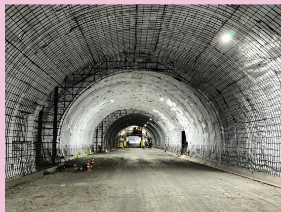
②トンネル本坑の施工状況(覆工)
