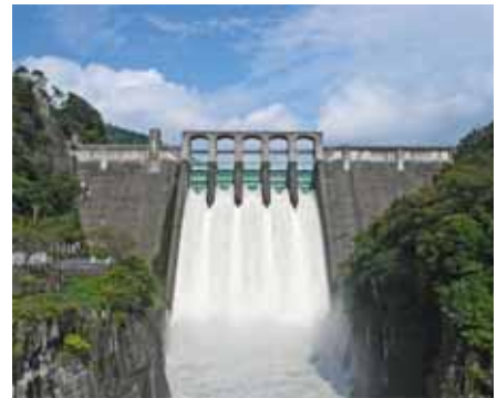
図ー4 丸山ダム
