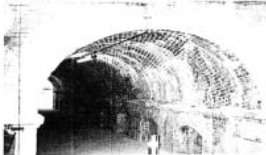
イギリス積みの角部に「羊かん」を用いず、「七五」を使った積み方。
