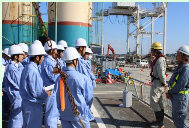
10月31日・11月1日 岡崎工業高校生が三河港神野地区耐震強化岸壁工事を見学 若手技術者の経験談を真剣に聞く未来の技術者達 (三河港湾事務所)
