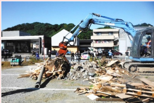
建設業、レンタル、解体業が連携した機の手配とガレキの撤去訓練の様子
