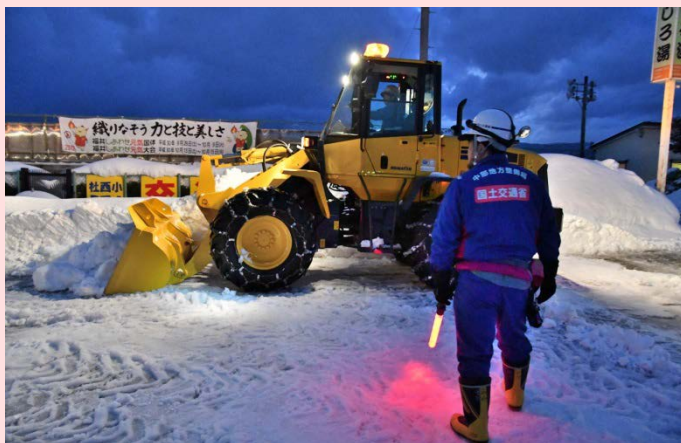
2月12日 除雪作業中の様子 福井県 緊急災害対策派遣隊(TEC-FORCE) (岐阜国道事務所)
