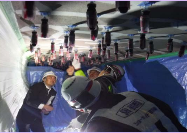
コンクリートのひび割れに樹脂を注入
