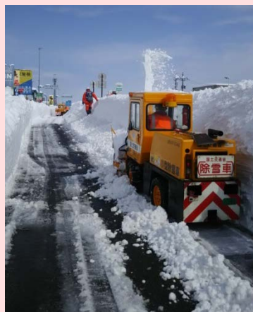
小型除雪車による側道及び歩道の除雪 2月7～9日 福井の大雪に高山国道から除雪支援 (高山国道事務所)
