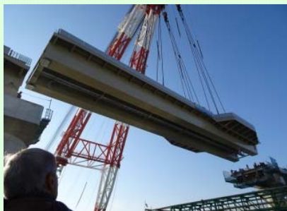
12月23日 四日市港霞4号幹線の見学会を開催 最後となる巨大橋桁の海上架設の様子を見守り無事架設が完了しました (四日市港湾事務所)
