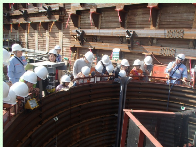
10/22 由比地すべり対策事業 親子見学会② 工事説明の様子
