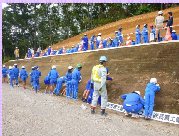
10/12 中部縦貫自動車道の工事現場で小学生が地層を学びました(高山市丹生川町) 地域の小学6年生が工事現場で理科の授業を実施(高山国道事務所)
