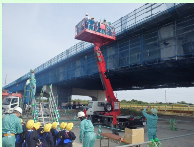
10/17 東海環状自動車道 高田北高架橋 岐阜県養老町立笠郷小学校1年生が高架橋の工事現場を見学
