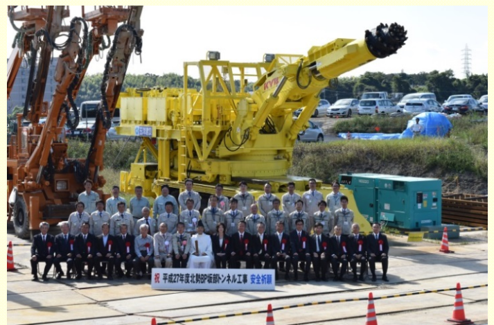
10/18 「北勢バイパス坂部トンネル安全祈願祭」② 坂部トンネル終点側坑口にて、日本で2台しかない 自由断面掘削機の前で集合写真
