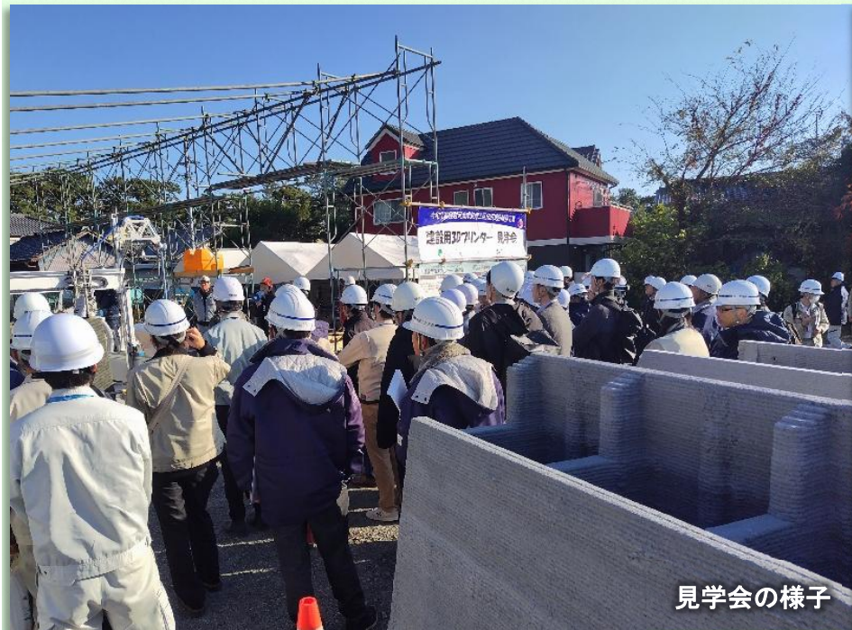
建設用3Dプリンターによる埋設型枠製作状況
