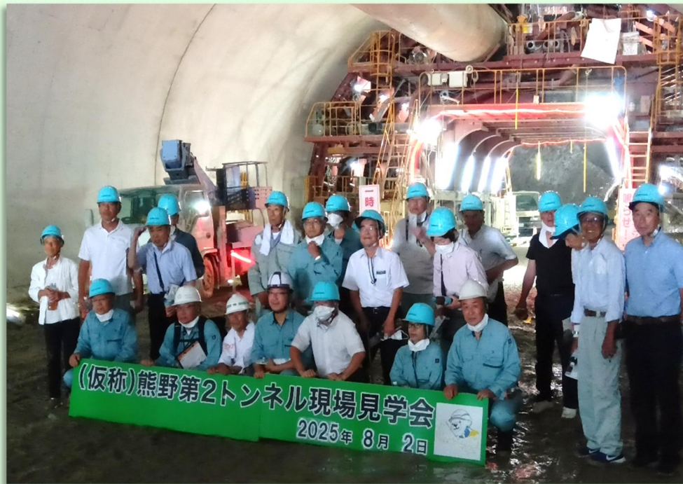
くまの・なんぐんせいふくぎちようかい 8月2日(土) 熊野・南郡正副議長会の26名が掘削中のトンネル工事現場を視察！
