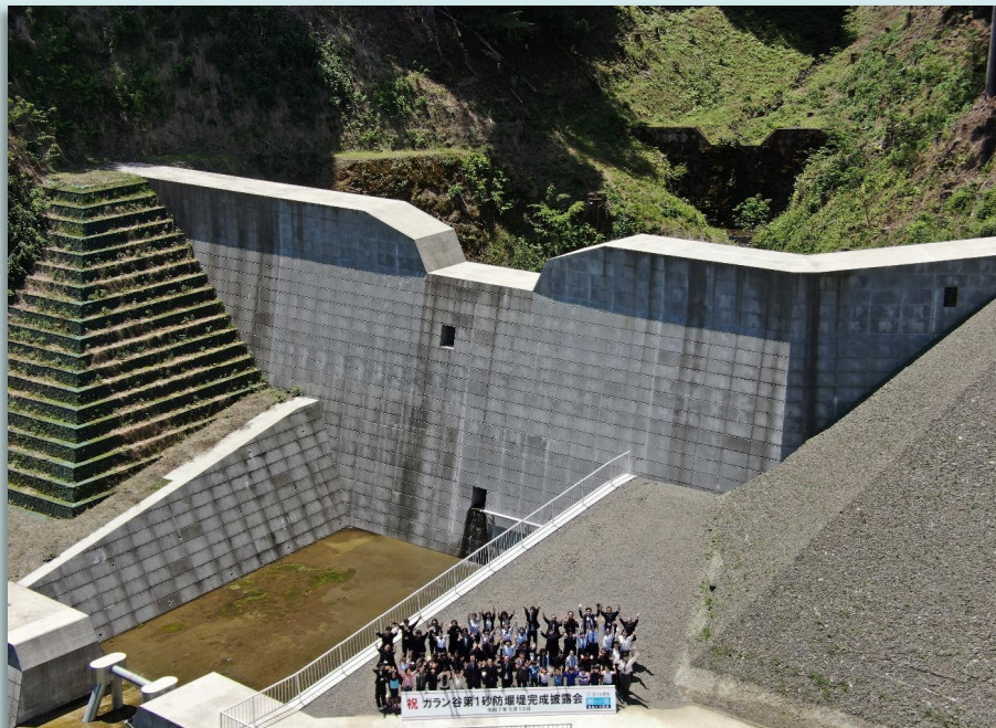
5月13日(火) ガララン谷第1砂防堰堤完成披露会を開催！
