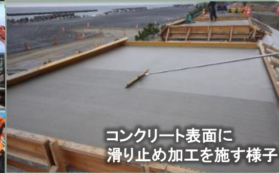
施工の様子 天端コンクリート打設
