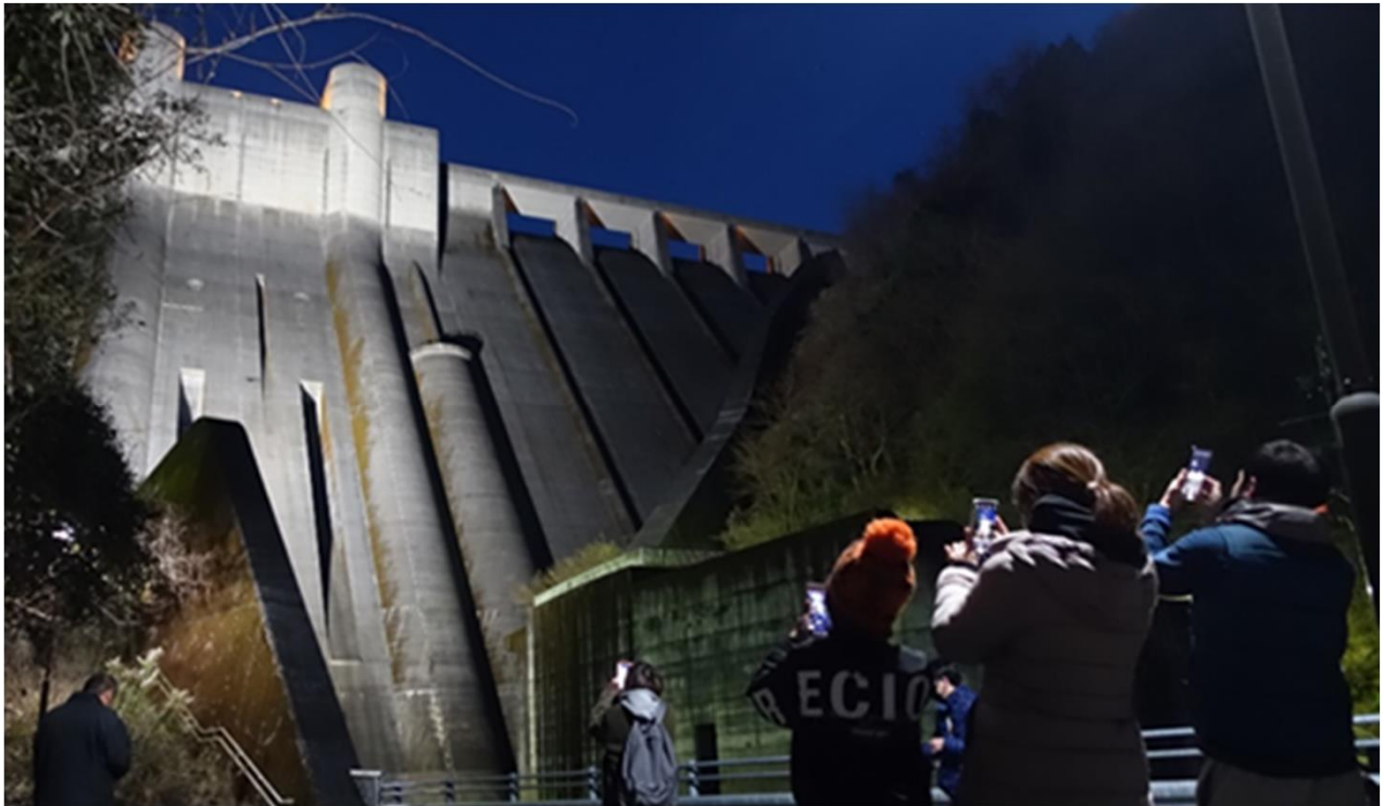
小里川ダム20周年ライトアップイベントを実施！
