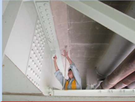
床版からの排水が橋梁本体(桁部)にかかっていたため、市販のホースをテープで固定し排水管を設置。(9月20日(金))
