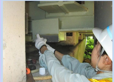
橋の部材に錆が発生していたため、ワイヤーブラシにて錆を除去。錆を除去した箇所に防錆材を塗布。(9月20日(金))
