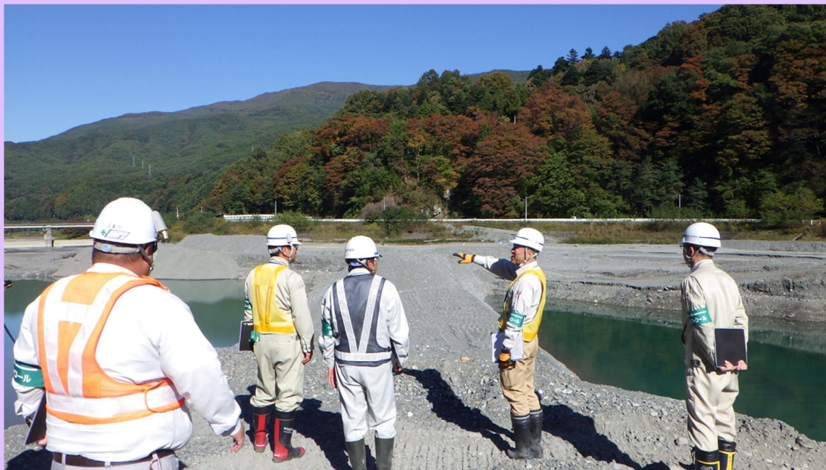
10月17日(火) 工事安全パトロールを実施！
