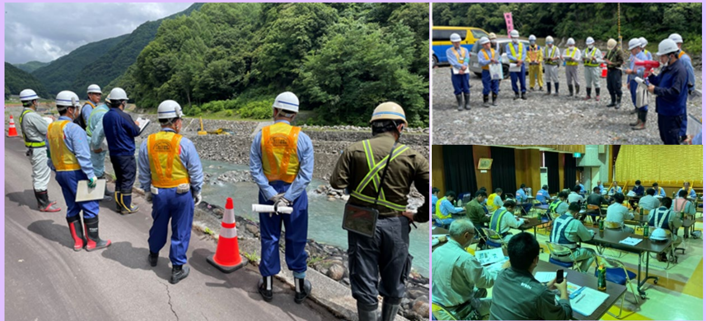
8月9日(水) 工事現場パトロールを実施！
