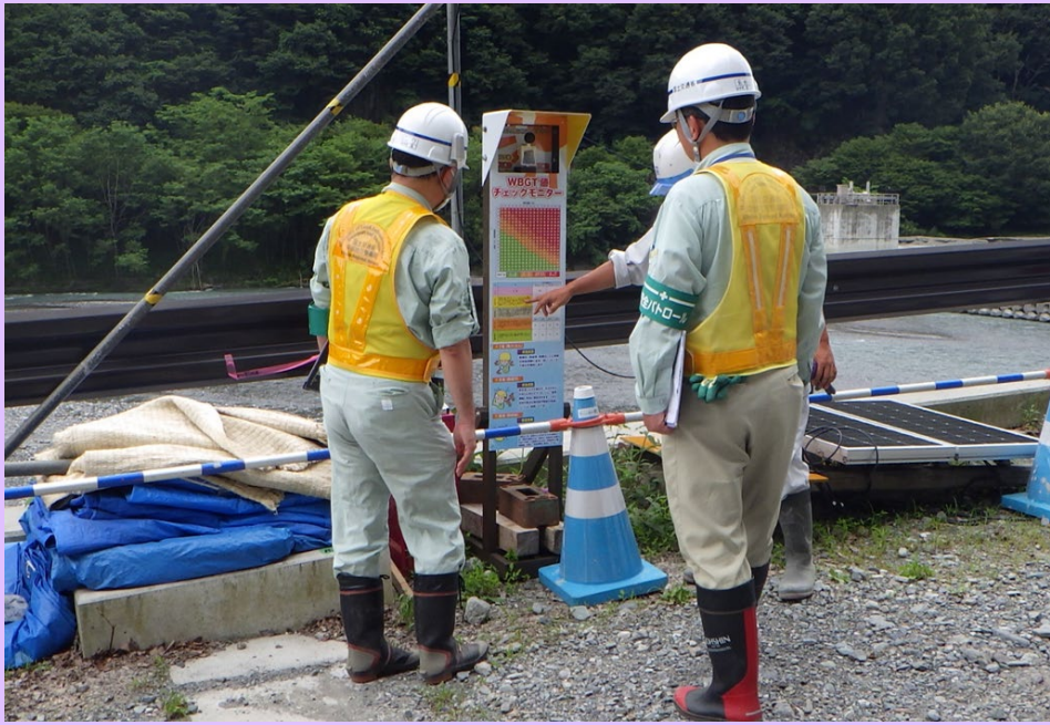
7月19日(水) 工事安全パトロールを実施！
