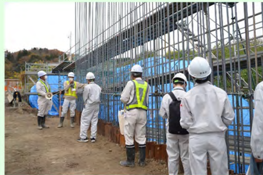
横断函渠の鉄筋組み立ての説明
