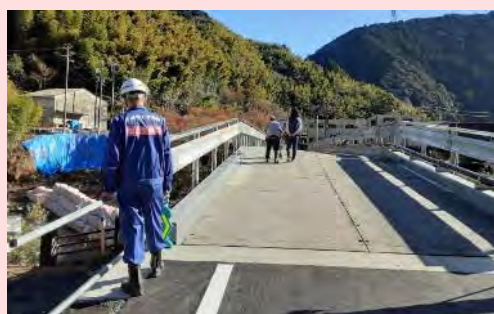
応急組立橋を確認している様子
