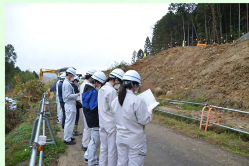
建設ICTを活用した切土工事
