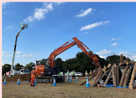
障害物の撤去作業
