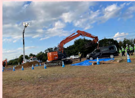
災害被災車両の撤去
