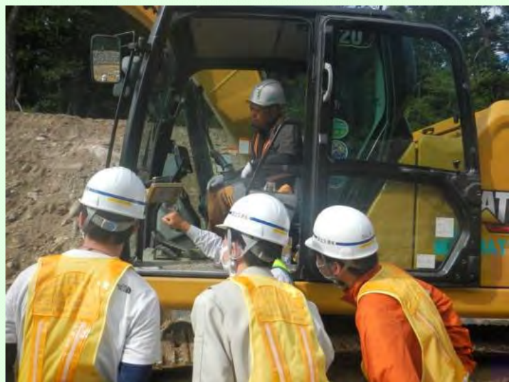
ICT施工体験の様子
