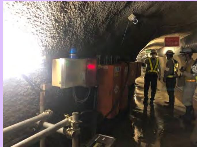
由比地すべり対策事業の排水トンネルにおいて、安全パトロールを実施しました。非常に狭いトンネル内での作業となるため、坑内の酸素濃度などの測定はもちろんのこと、坑外でも作業状況を確認するための監視カメラや非常電話、非常ベルを設置し、安全第一に気を配り作業を進めております。(静岡県静岡市)
