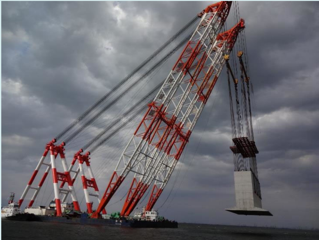
5月3日(火)～5月11日(水) 金城ふ頭岸壁ハイブリッドケーソンの運搬
