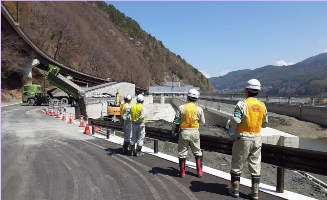
4月20日(水) 工事安全パトロールを実施
