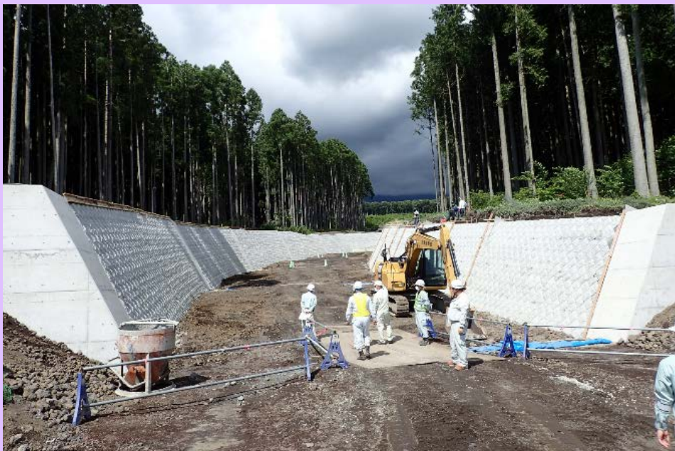
6月17日(木) 管内工事安全パトロール 富士宮
