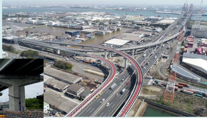
飛島JCT(伊勢湾岸道と接続)
