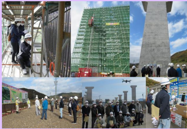
11月15日(日) 岐阜市方県連合会の皆様29名が 東海環状自動車道岐阜IC工事現場を見学 (岐阜県岐阜市) 【岐阜国道事務所】
