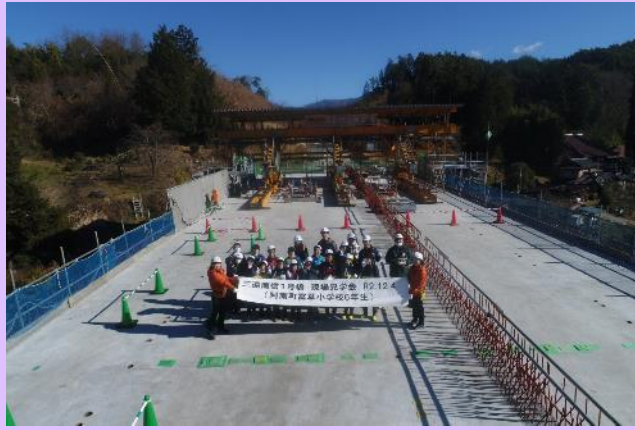
12月4日(金) 阿南町立富草小学校6年生19名が 三遠南信道飯橋道路の橋梁工事を見学 (長野県飯田市) 【飯田国道事務所】
