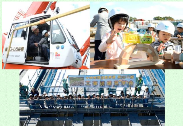
10月28日 三枝保育園の園児25名が 中部縦貫道高山IC工事現場を見学 大型クレーンの操作や、アーチブロック組み立てなどを 体験しました。(岐阜県高山市) 【高山国道事務所】
