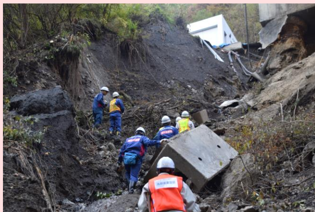
11月2日 国道361号権兵衛峠道路の直轄権限代行による 復旧事業を推進中 崩落した斜面の調査の様子。(長野県箕輪村) 【飯田国道事務所】
