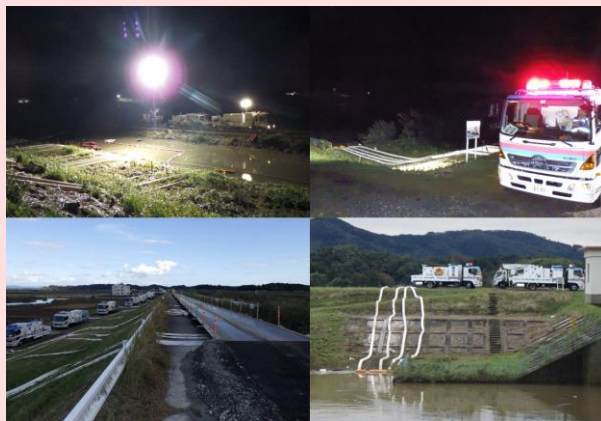
10月22日～26日 TEC-FORCEを派遣(台風19号への対応) 宮城県大崎市、角田市、松島町へ排水ポンプ車、 照明車を派遣し排水作業を行いました。 【天竜川上流河川事務所】
