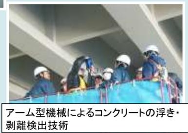
アーム型機械によるコンクリートの浮き・剥離検出技術
