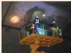
トンネル点検
