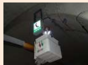
誘導表示板点検
