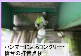
ハンマーによるコンクリート橋台の打音点検
