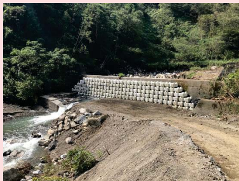
(9月17日)下流側対策後
