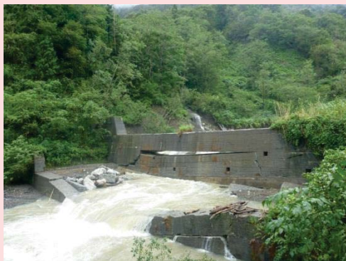
(9月10日)下流側対策前
