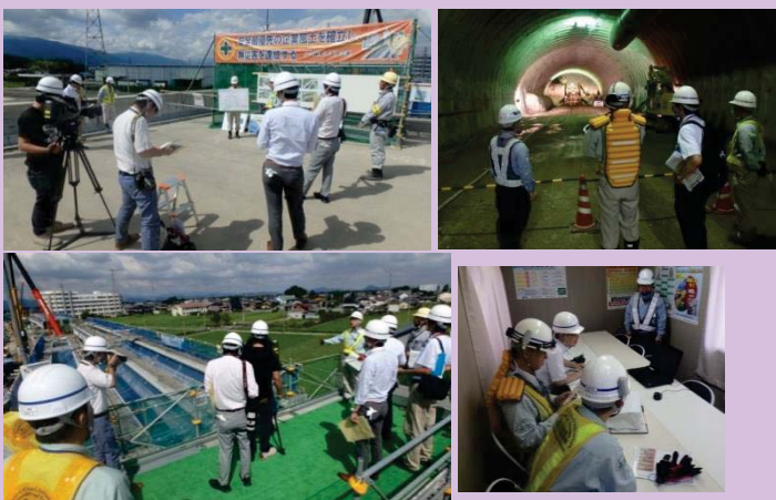
9月3日 東海環状自動車道 報道関係者向け現場見学会 2019年度の開通を目指す東海環状自動車道の橋梁、トンネル建設現場にて、報道関係者を対象とした現場見学会を開催しました。(岐阜県大垣市・岐阜市・関市) 【岐阜国道事務所】
