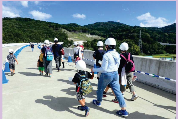
8月21日 天城北道路 夏休み親子現場見学会 親子が橋の上をウォーキング。(静岡県伊豆市) 【沼津河川国道事務所】
