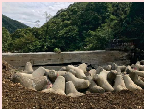
(9月17日)上流側対策後
