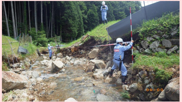
7月11日～13日 下呂市内で河川現地調査を行いました。
