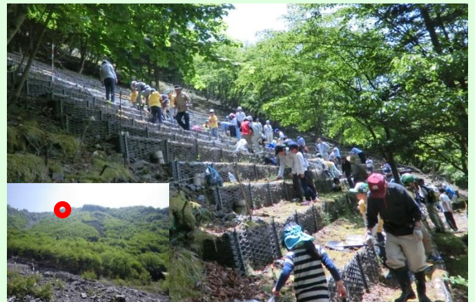
5月27日 大谷崩植樹体験(静岡市葵区大谷) 砂防工事(山腹工)により造られた平坦な部分に植樹をする参加者。 (静岡河川事務所)
