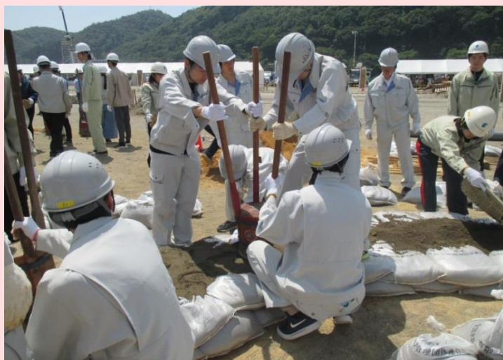
大学生による水防工法(月の輪工)
