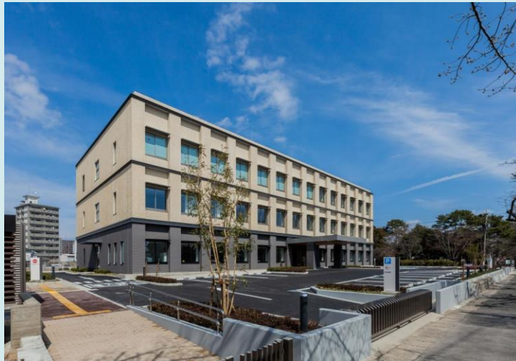
5月24日 岐阜地方・家庭裁判所大垣支部庁舎の落成式 新庁舎の外観(正面) (営繕部)
