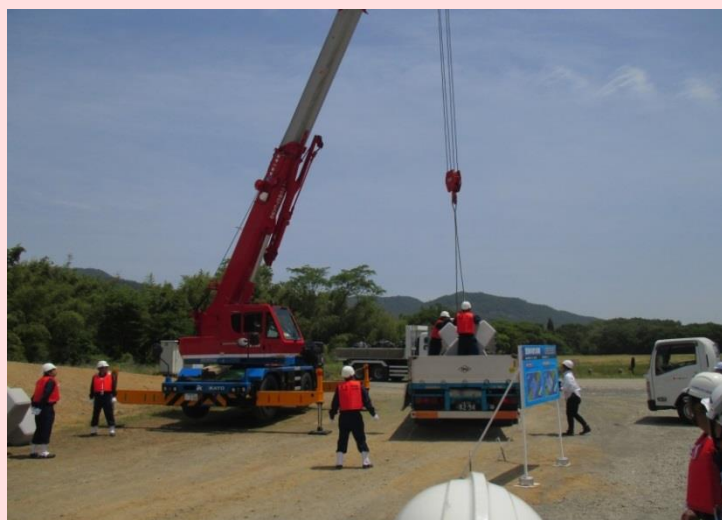
堤防決壊の荒締め切り工
