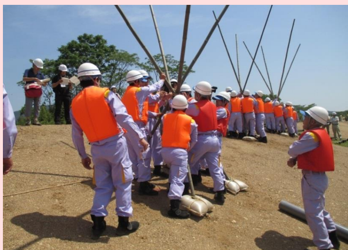
水防団による水防工法(五徳縫い工)
