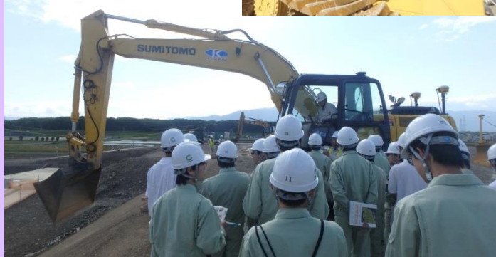
5月9日 岐阜工業高等専門学校 環境都市工学科学生 が東海環状自動車道の大野神戸IC建設現場で 建設ICTを見学しました。 （岐阜国道事務所）
