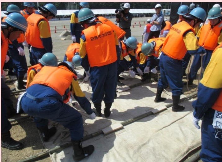
水防団による水防工法(シート張り工)
