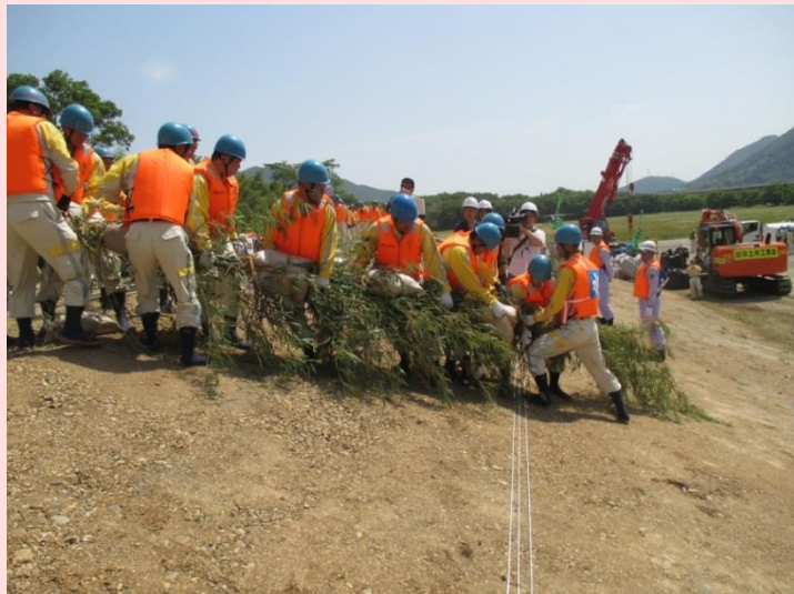
水防団による水防工法(竹流し工)
