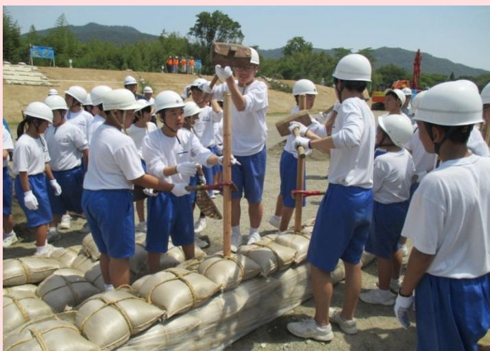
中学生による水防工法の実施(積み土嚢工)
