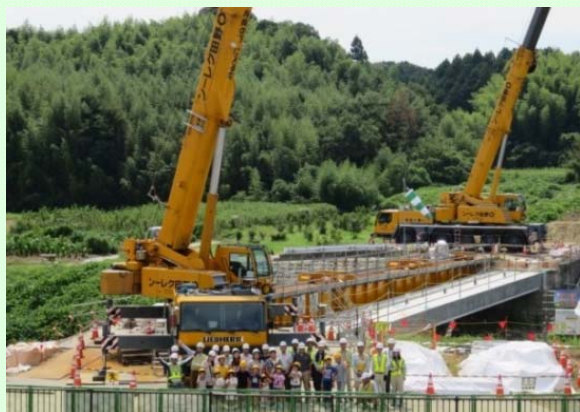
9月9日 橋梁架設に使用する大型クレーン2台と記念撮影 国道23号中勢バイパス現場見学会 (三重河川国道事務所)
