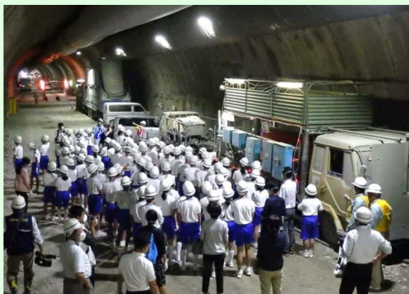
9月14日 石浦バイパス1工区宮峠トンネル工事現場見学会 久々野中学校生徒がトンネル 工事の説明を熱心に聞きました (高山国道事務所)
