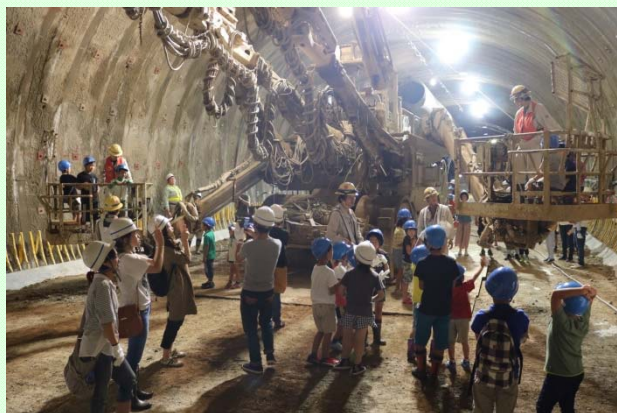
8月26日 中部縦貫自動車道高山清見道路 上野トンネル工事親子現場見学会を開催① 施工機械の試乗などトンネルの施工現場を体感しました (高山国道事務所)
