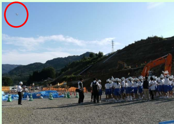
9月14日 石浦バイパス1工区宮峠トンネル工事現場見学会 久々野中学校生徒が建設ICTによる切土工事や ドローン(赤丸囲)の操作を見学 (高山国道事務所)
