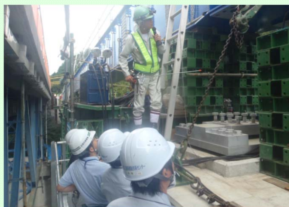
9月11日 自治体技術職員約30名が 橋梁の構造や架設工法について学びました② 将来メンテナンス(支取替)に備え ジャッキアップによる取替イメージを学習 (紀勢国道事務所)
