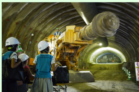
8月18日 天城北道路「夏休み親子見学会」② こどもたちが掘削機の操作を体験 (沼津河川国道事務所)
