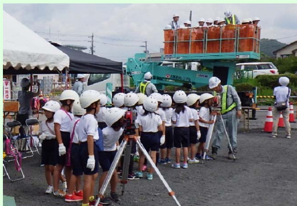
8月1日 東海環状自動車道 現場見学会 富岡小学校児童が橋梁下部工事現場で測量や高所 作業車乗車など現場体験を行いました (岐阜国道事務所)
