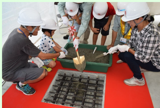
8月18日 天城北道路「夏休み親子見学会」① 親子がコンクリート打設を体験 (沼津河川国道事務所)
