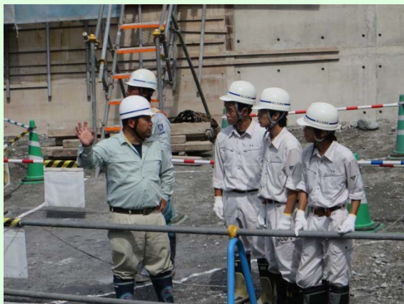
8月23～24日 高校生(3名)のインターンシップ 砂防工事現場の説明を熱心に聞き入る高校生たち (天竜川上流河川事務所)
