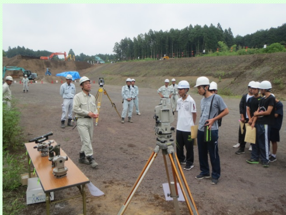
8月10日 フィールドワークにて静岡県下の高校生が 現場見学(鞍骨沢遊砂地工事)③ 測量機器の進化を学ぶ (富士砂防事務所)
